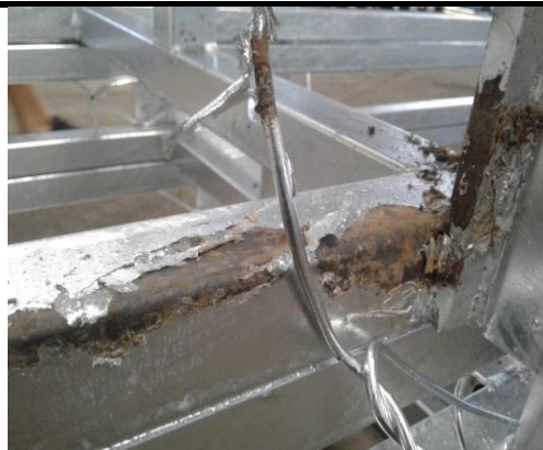
Naprawiana powłoka zgodnie z punktem 5 WTO
