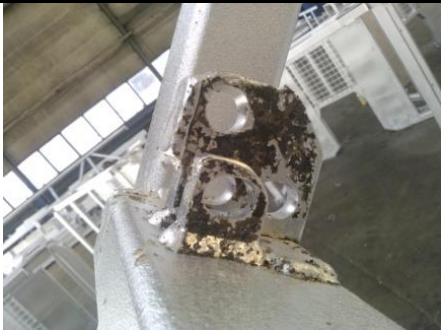
Znečištění oceli, stopy po nálepkách způsobují nepozinkovaná místa – neopravují se
