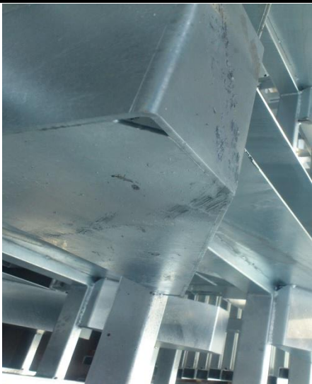
Místa po věšácích (drátech), stopy po popelu – neopravují se
