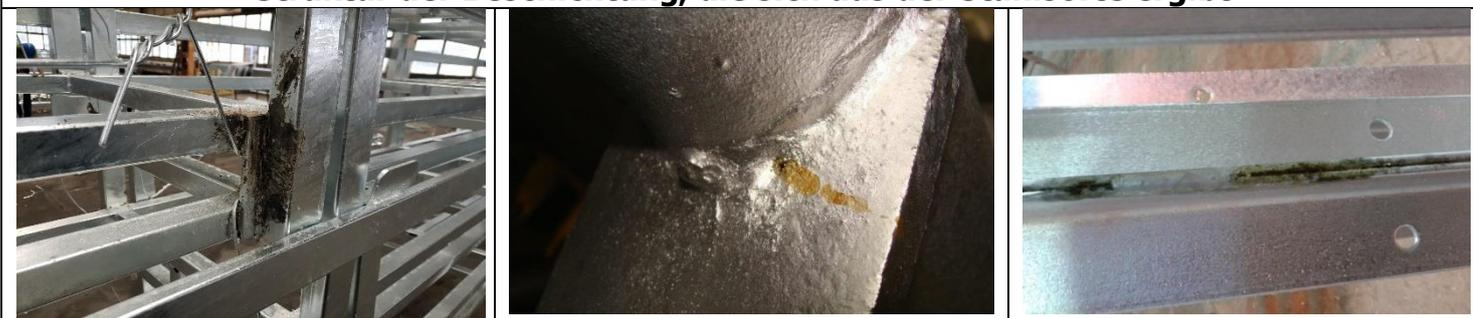
Undichte Schweißnähte - Ausbrüche und Lecks werden nicht behandelt
